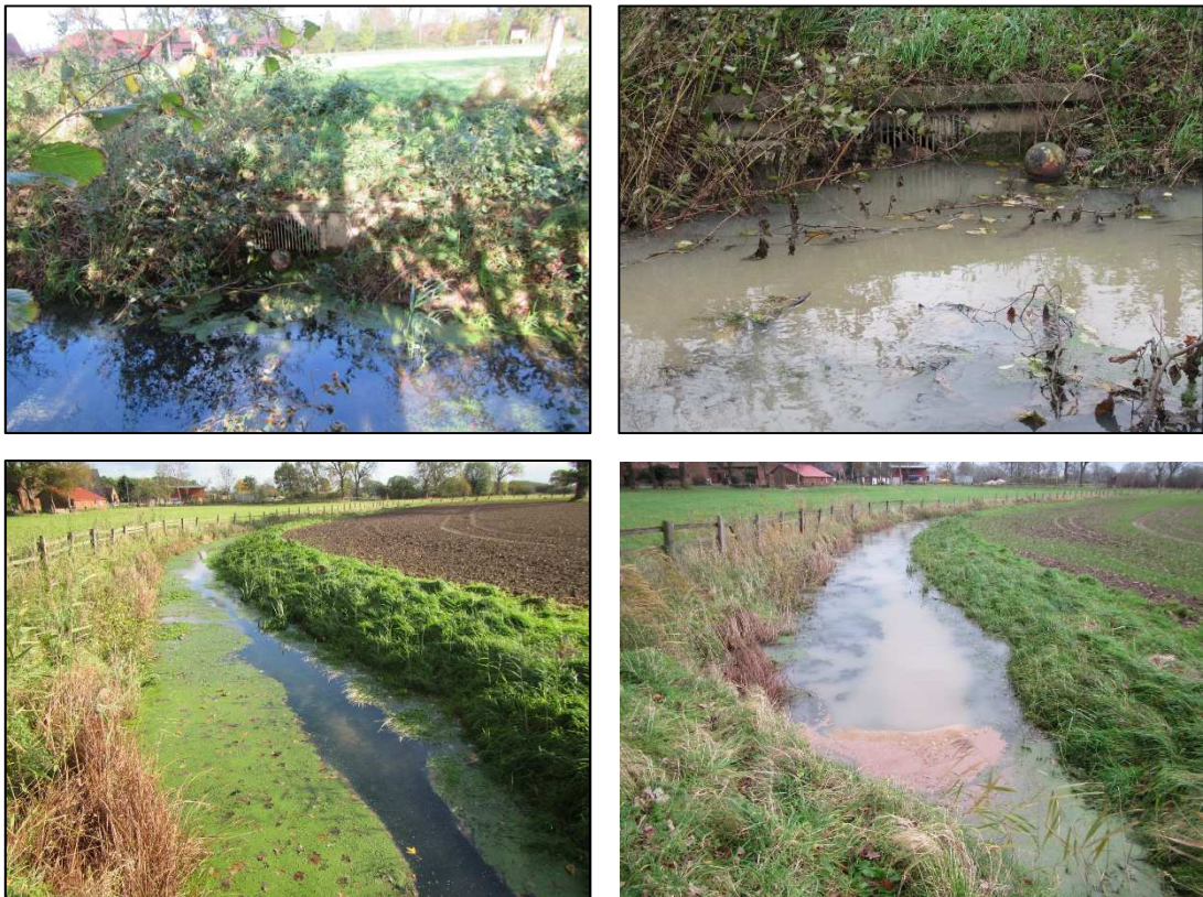
Abb.6.2-4: Zulauf zur Rohrleitung (oben) und Blender Hauptgraben (unten) kurz vor der Querung des Seestedter Richtwegs in einer „Normalsituation“ (links) und bei Starkregen.
